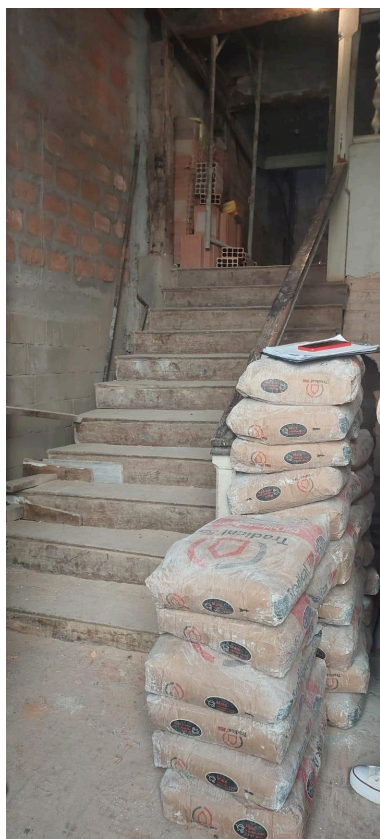
Escada de entrada da edificação Autoria: Maria Letícia Ticle Data: 20/05/2024
