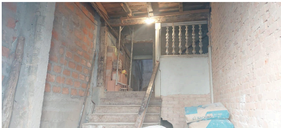
Reboco das alvenarias da entrada removidos Autoria: Maria Leticia Ticle Data: 20/05/2024
